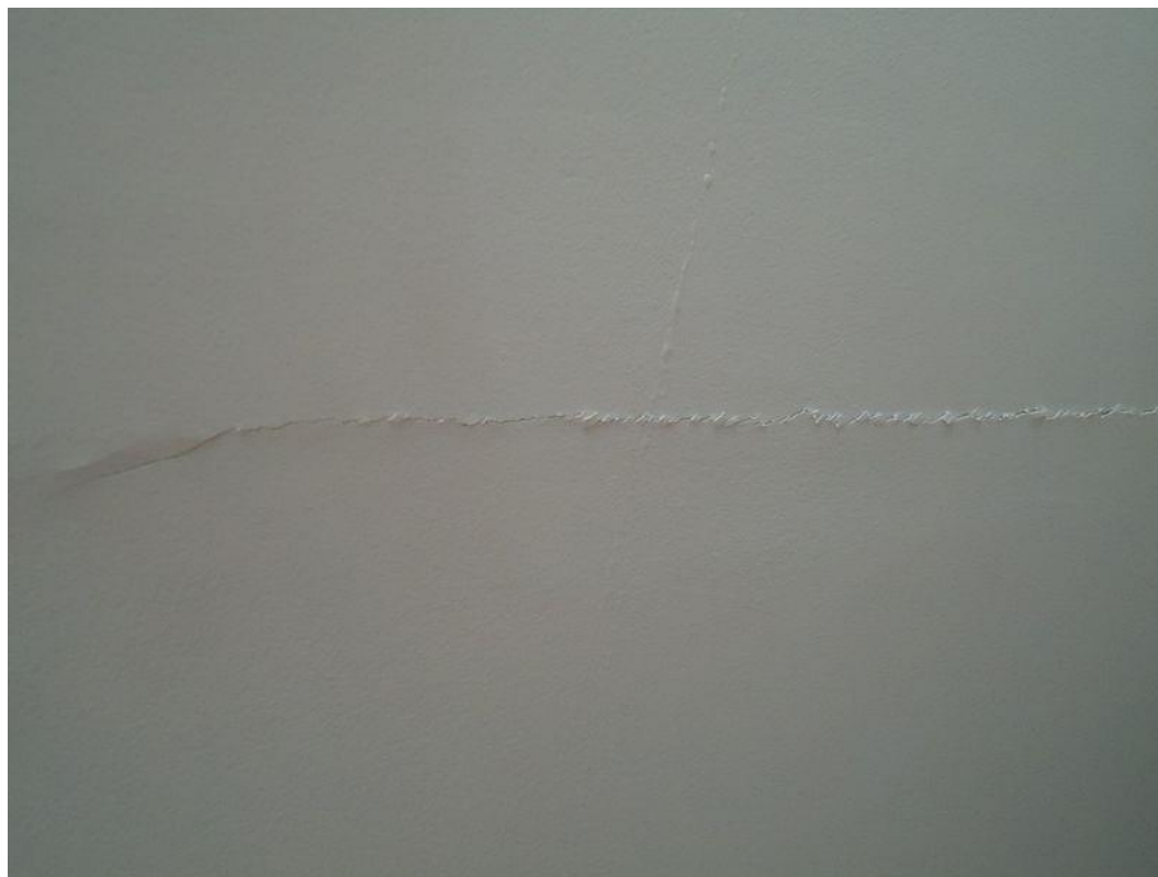
FOTO 06 - Forro de gesso trincado no pavimento superior
