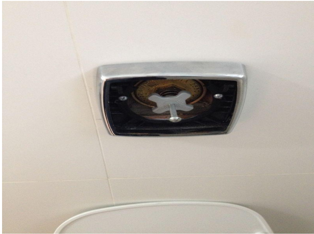
FOTO 08 - Acabamento de válvula de descarga
