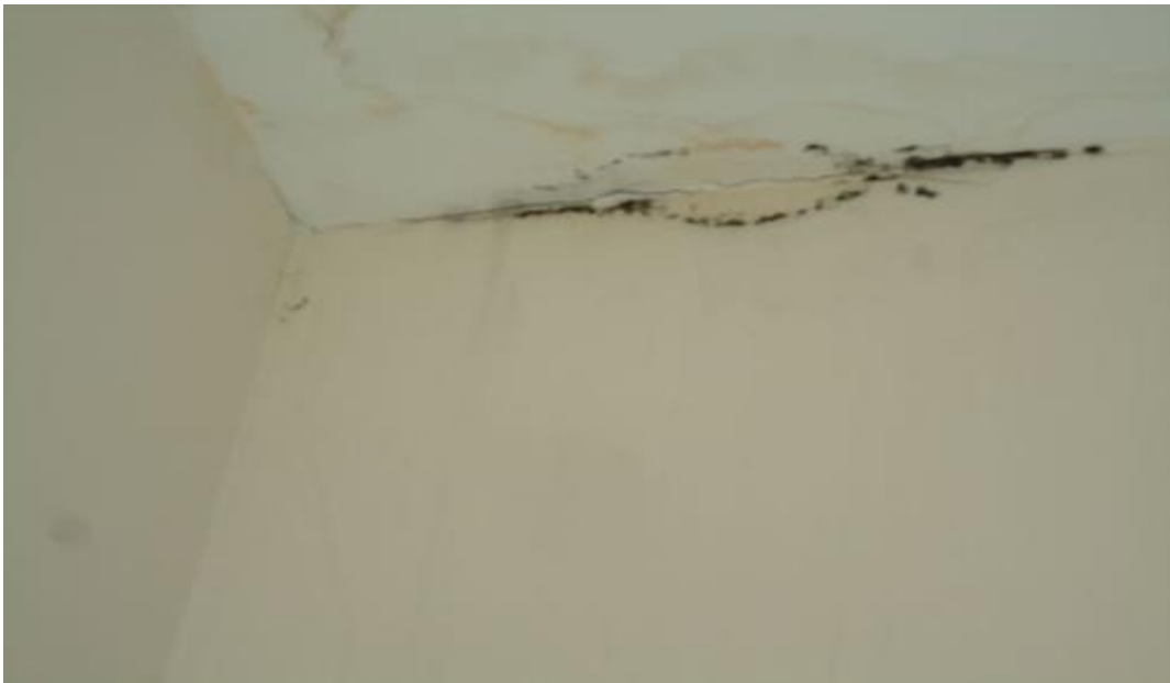
FOTO 03 - Infiltração no forro de gesso
