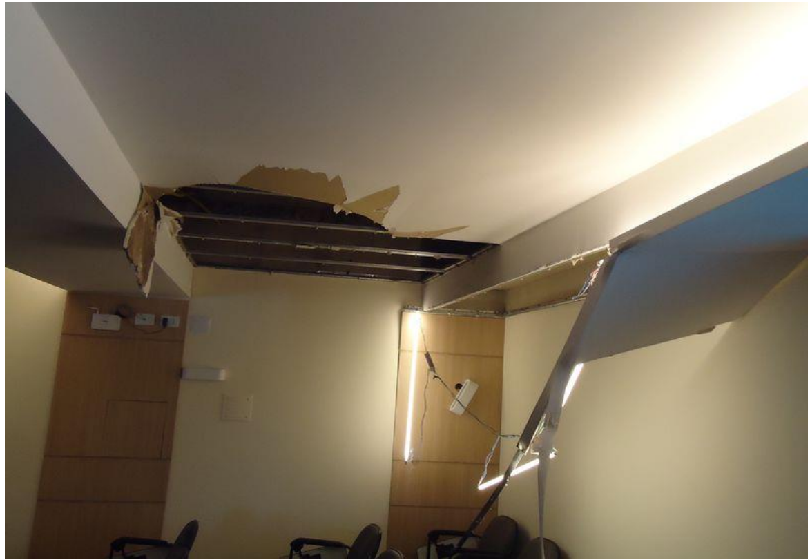
FOTO 04 - Forro de gesso do auditório
