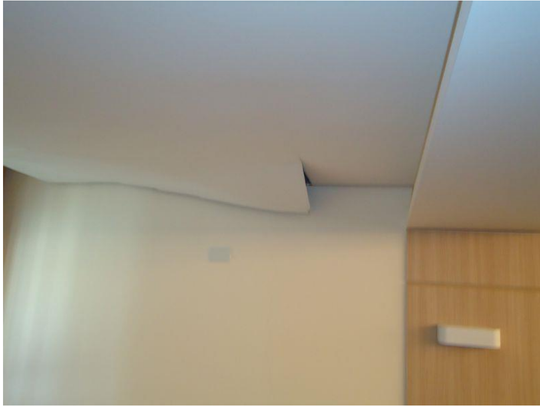
FOTO 05 - Forro de gesso do auditório
