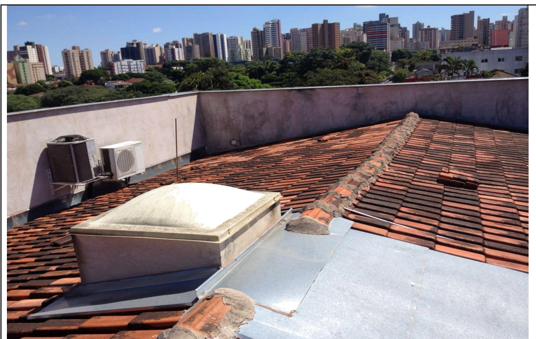
FOTO 01 - Telhado a ser trocado
