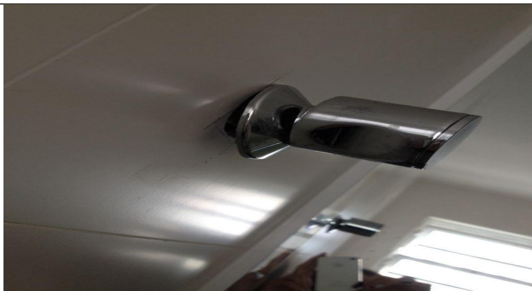
FOTO 09 - Acabamento de registro
